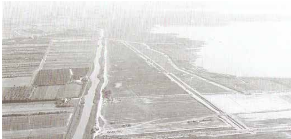
Prima delimitazione del piazzale e della pista di rullaggio; gli automezzi accedono alle zone arenose attraversando l'Osellino in località Pagliaghetta e percorrendo una strada in terra battuta.
